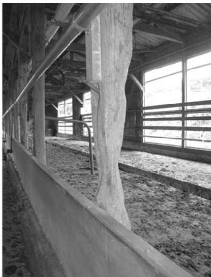
(写真1) 牛がかじって半分ほどの太さになった牛舎の柱 (半杭さんの牛舎で2012年11月10日撮影)
