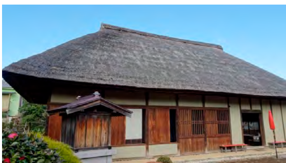
鹿窓は、室内から外の様子が分かるよう工夫されている。
