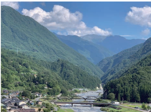
遠景に赤石岳。三連アーチの橋梁は国登録有形文化財の小洪橋。
