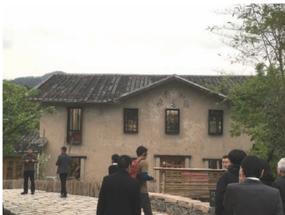
写真3 旧水力発電施設
