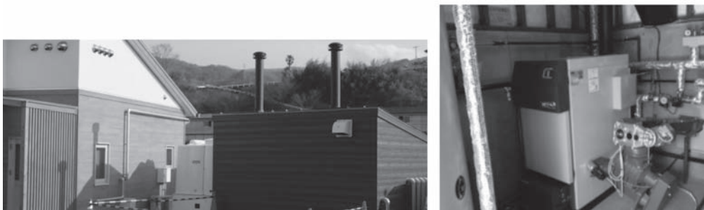
(図9) さくら診療所敷地内のボイラー庫（煙突のある建屋）と設置されたボイラー2基のうちの1基
