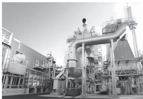
（図2） 那珂川工場敷地内の木質バイオマス発電所
