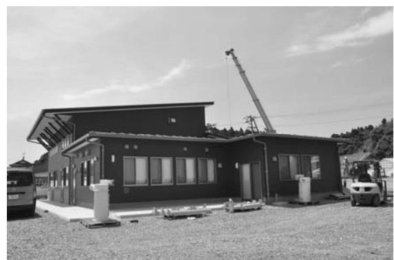
完成した製粉工場
