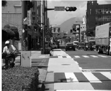
自転車専用通行帯の走行方向に合わせて道路標示の向きを変更
