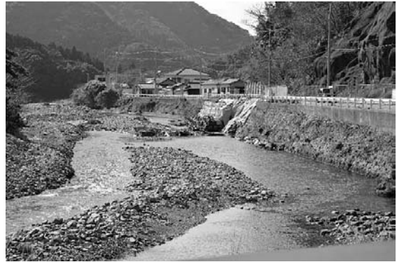
水害で陥没した道路（対馬市撮影）
