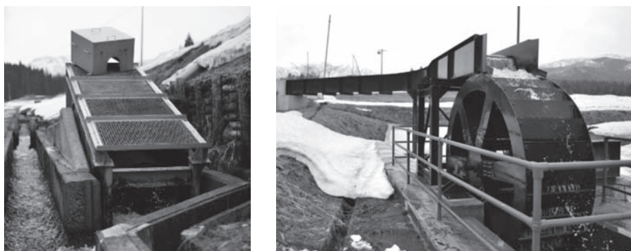
図2 石徹白のらせん型水車（出力：常時500W／最大800W、左）と上掛け式水車（出力：常時750W／最大2,200W、右）
