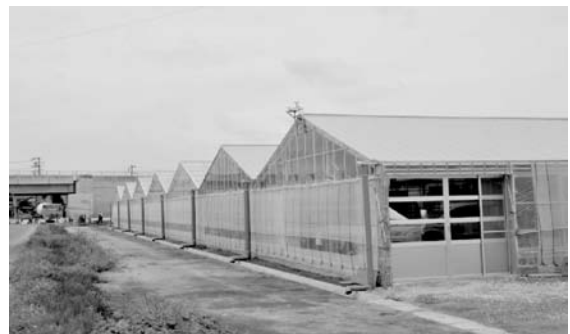
完成した施設園芸団地
