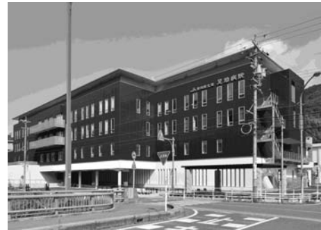
(写真1) 足助病院全景
