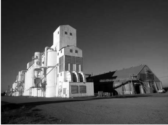
写真5-1 ステゲマンの乾燥貯蔵施設 2009/08/26撮影
