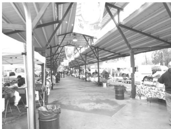
写真1 セントラルパーク会場の雨除け構造物 出所) 筆者撮影。2010/1/24
